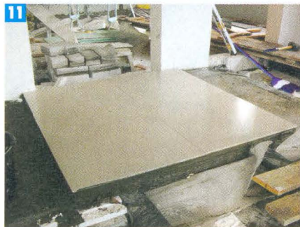
11 Бетонное основание для печи-камина облицевали плитками керамогранита.
