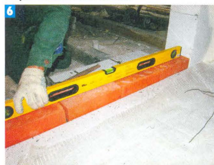
6 Выложив всухую кирпичи первого ряда кладки щитка, проверили уровнем его горизонтальность.
