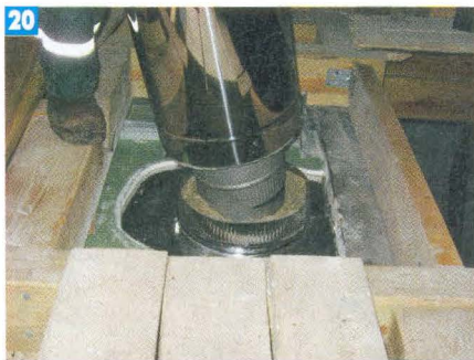
20 Пришёл черёд монтажа сэндвич-дымохода из нержавеющей стали.
