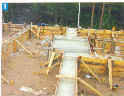
1 При закладке основного фундамента для дома предусмотрели и железобетонный фундамент для кирпичного щитка.
