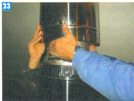
23 Соединять секции сэндвич-дымохода лучше вдвоём.
