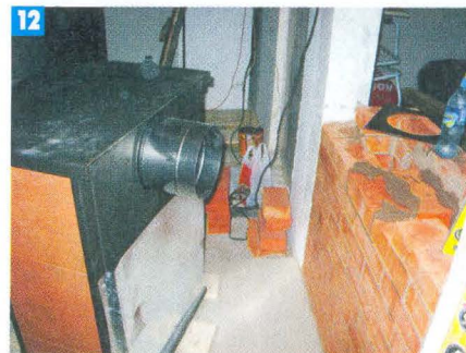
12 Выложив щиток до нужного уровня, подготовили печь-камин к сопряжению с ним.
