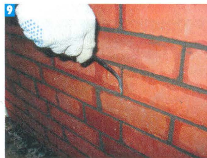
9 Швы кирпичной кладки расширяли сразу же, пока раствор не затвердел.
