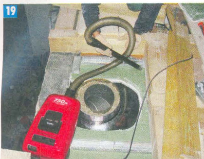
19 Из зоны противопожарной разделки убрали строительный мусор и тщательно её пропылесосили.
