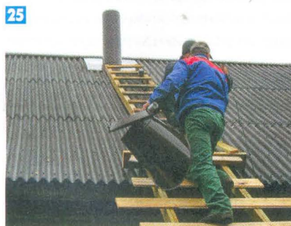
25 Монтаж наружной части дымохода — ответственная работа: дождь и снег не должны попасть под кровлю.
