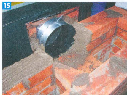
15 Стык фланца дымохода с кирпичной кладкой уплотнили огнеупорной смесью.
