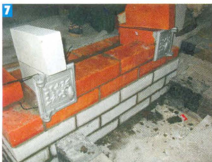
7 Уже на 2-м ряду кладки установили прочистные дверки.
