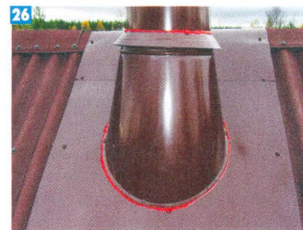
26 Стыки наружных элементов, защищающих проход через кровлю, промазали герметиком.
