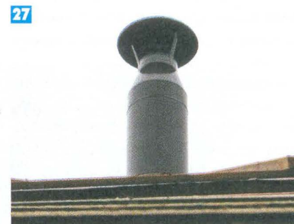
27 Возведение наружной части дымохода завершили установкой колпака.
