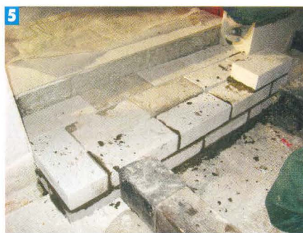
5 Основание щитка выложили из силикатного кирпича.
