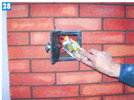
28 Перед проведением первой пробной топки печи проверили тягу в дымооборотах щитка.
