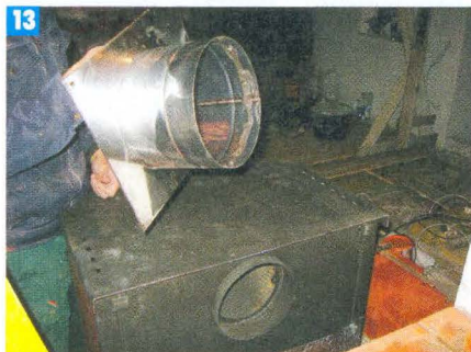
13 Для сопряжения печи и щитка использовали фланец-дымоход из нержавеющей стали.
