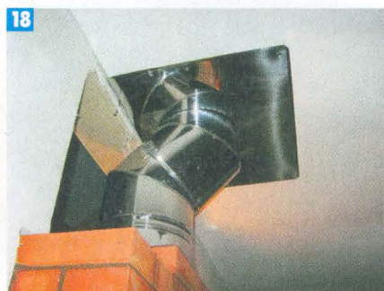
18 Сверху щитка установили переходной элемент для сопряжения с сэндвич-дымоходом.
