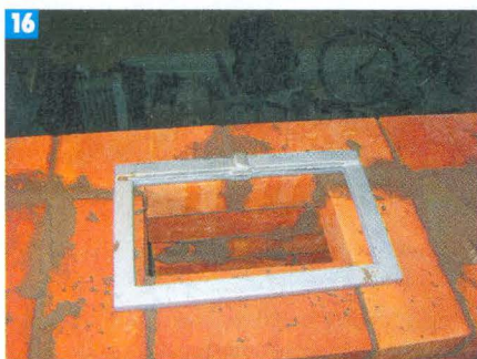
16 На 30-м ряду кладки на дымоход установили задвижку.
