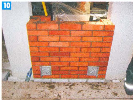
10 Прочистные дверки обеспечивают доступ в нижнюю часть дымооборотов «зимнего» хода.
