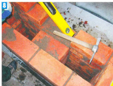
8 Дымообороты выкладывали в полкирпича.
