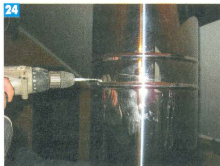
24 Секции наружного контура дымохода скрепляли саморезами.
